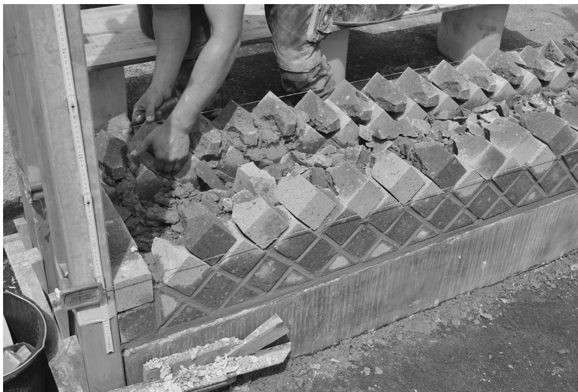
Abb. 4: Schale und Kern der Retikulatmauer im Aufbau.
