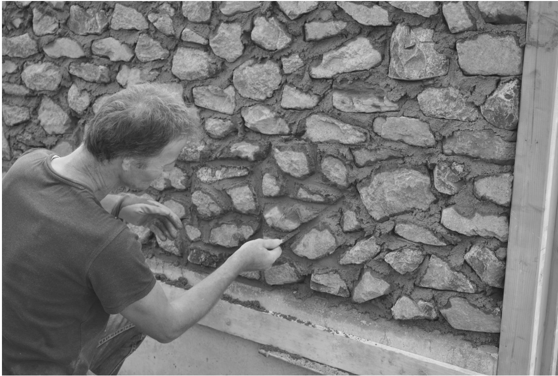
Abb. 6: Verfugen der Incertummauer. Im rechten und oberen Teil der Mauer die unbearbeiteten Fugen zum Vergleich.
