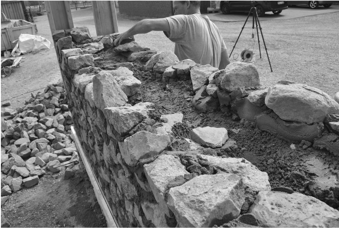
Abb. 8: Schale und Kern der Bruchsteinmauer im Aufbau.
