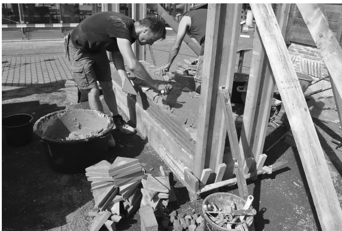
Abb. 5: Schale und Kern der Ziegelmauer im Aufbau.
