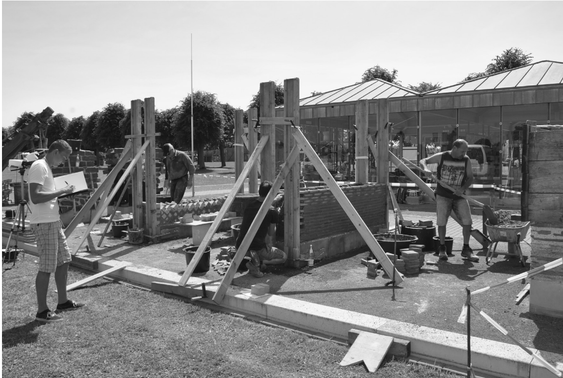
Abb. 3: Baustelle im LVR-Archäologischen Park Xanten.
