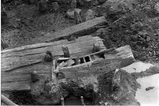
Abb. 4: Die Pfahlgründung und die Wasserrinne mit Blick nach Nordosten.
