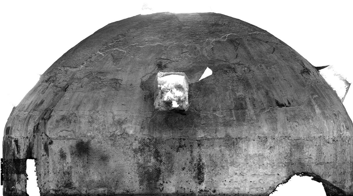
Abb. 21: Orthobild aus PhotoScan mit der Fehlstelle im Kuppelbereich.
