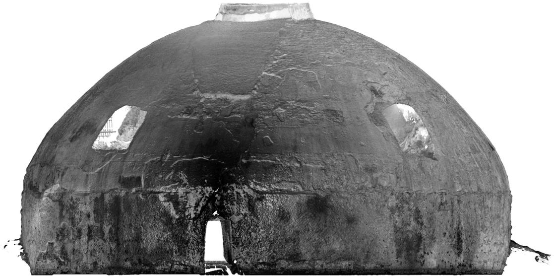
Abb. 22: Orthobild der Punktwolke aus dem Laserscan.
