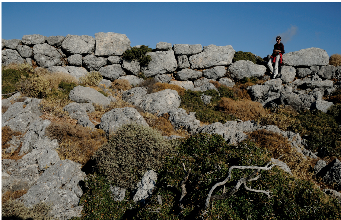
Abb. 9: Hyrtakina, Abschnitt der südwestlichen Stadtmauer, Landseite.
