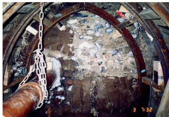
Abb. 6: Köln, Ausschnitt einer römischen Fundamentplatte aus Gussmauerwerk mit Pfahlgründung im unterirdischen Kölner Stollen auf Höhe Quatermarkt.
