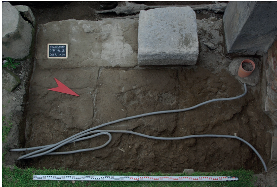
Abb. 9: Pompeji, Mörtelunterbau für den Plattenboden des ‚comitium‘.
