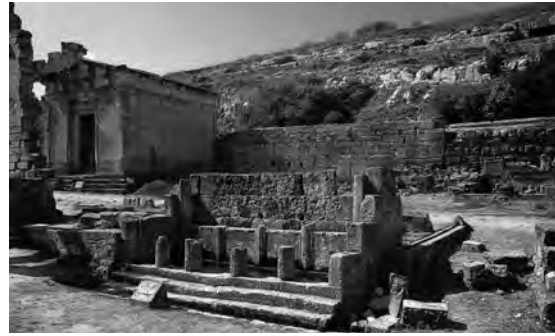
Abb. 9: Stützmauer der Quellterrasse westlich des Schatzhauses der Strategen (19), im Vordergrund das ‘Dorische Brunnenhaus’ (34).
